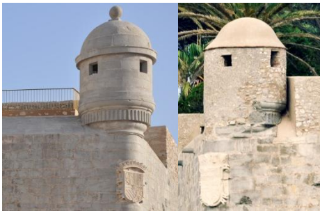
Figs. 8 y 9- A la izquierda garita original y a la derecha otra reconstruida en el siglo XX que conserva parte de la base (M a Josefa Balaguer, 2013)
