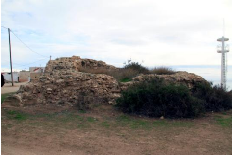
Fig. 8- Restos de la torre en la playa del Pinet (Santiago Varela, 2014).
