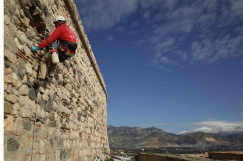
Fig. 8.- Reparación del frente del baluarte sur del castillo de salobreña mediante el método de “trabajo de altura”. Vista tomada con un multicoptero provisto de cámara fotográfica.
